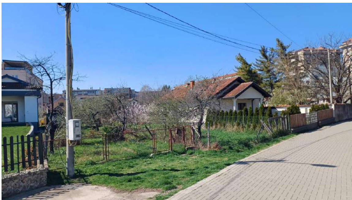
sl. 2 – izgled predmetnih parcela sa gradskog keja sa objektom predviđenim za rušenje
