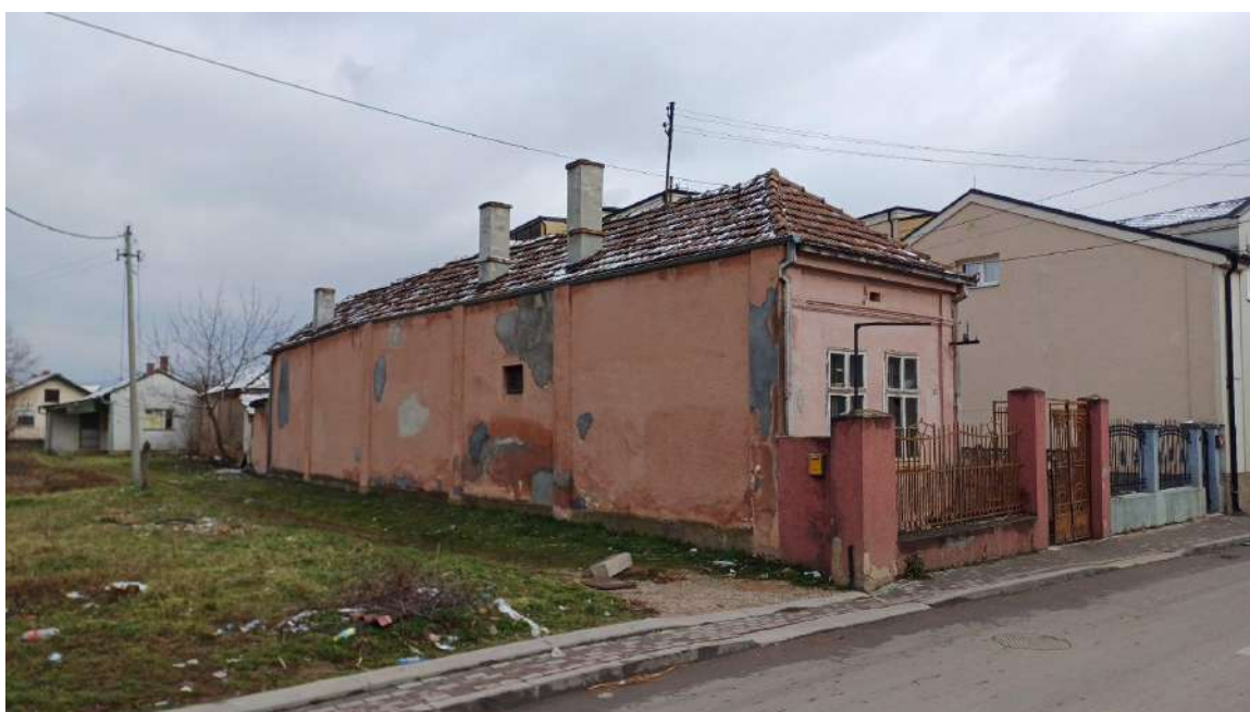
sl. 3 – izgled sa ul. Nikole Pašića jednog od stambenih objekata predviđenog za rušenje
